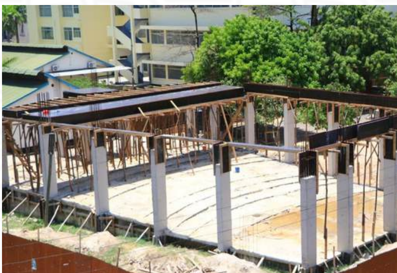
Muonekano wa ujenzi wa ukumbi wa mihadhara ISW
