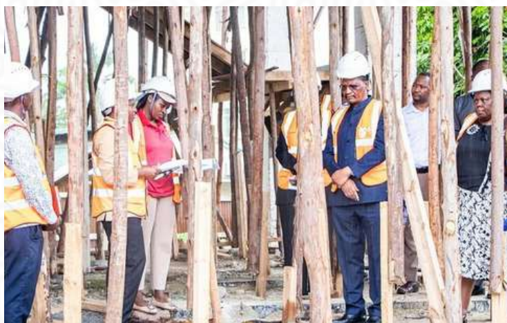
Katibu Mkuu WMJJWMM Dkt John Jingu (mwenye suti ya bluu) akikagua ujenzi wa ukumbi wa mihadhara ISW, Dar es salaam 17 Aprili 2025.
